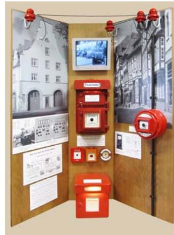
Die Darstellung der alten Feuermeldeanlage aus der Stadt Hameln konnte durch einen Feuermelder der Stadt Hannover (unten) und durch einen PC mit Bildschirm erweitert werden. Auf dem Bildschirm wird nach der Vorführung der Funktion der Feuermeldeanlage ein Video über die Entwicklung der Alarmierung durch Kirchenglocken bis zu den Anfängen der analogen Funkmeldeemp-
